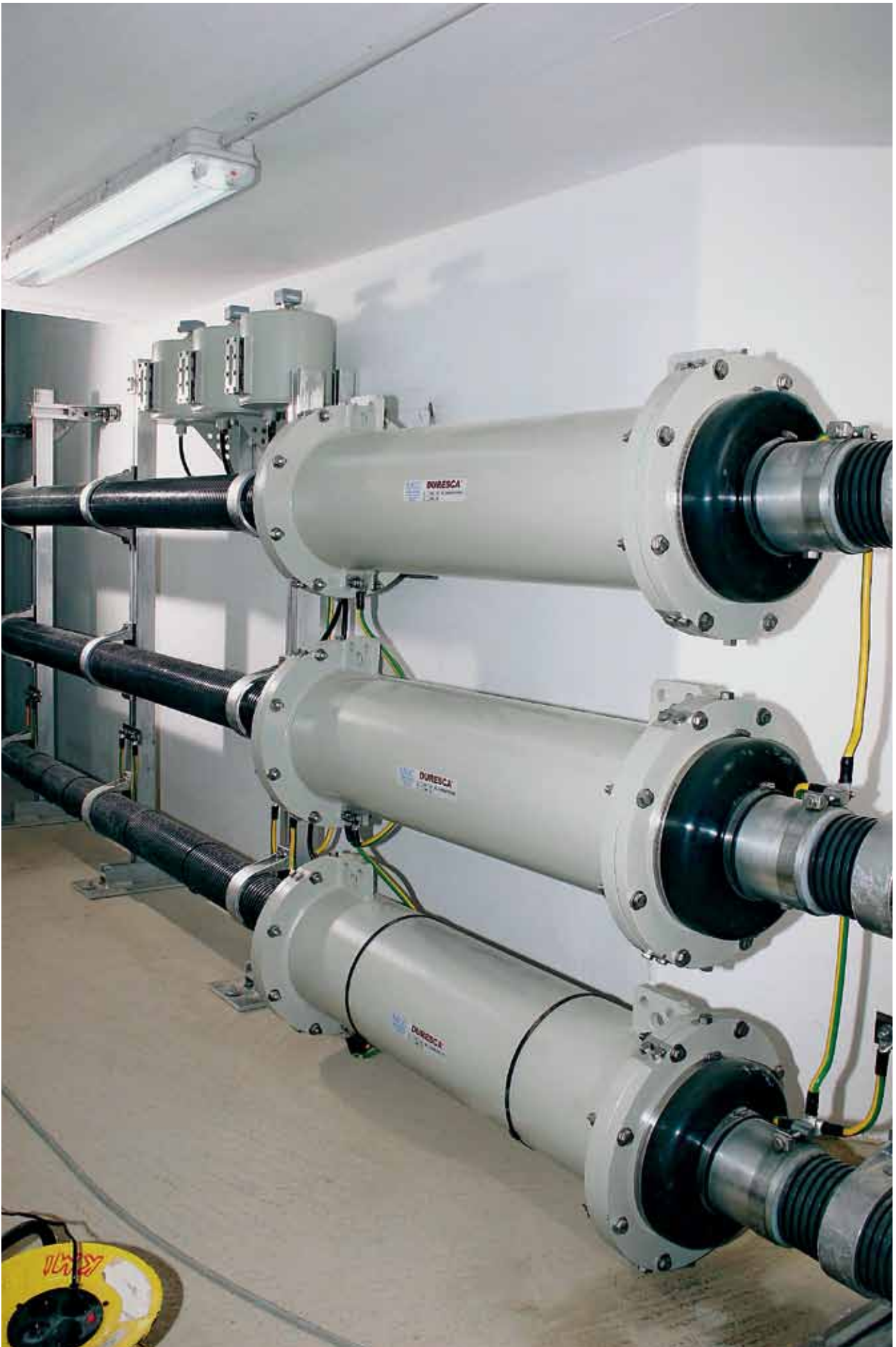
Токопровод DURESCA 123 кВ, 2000 А
