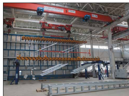
Предприятие подготовки металлоконструкций для горячего цинкования, г. Краснодар
