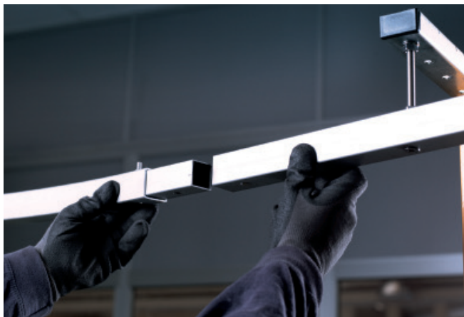
Стыковка секций с помощью соединительной муфты RG3502.
