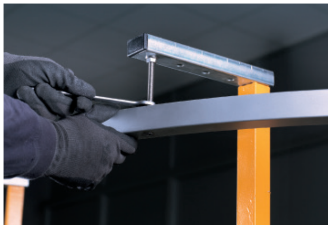
Корректировка рабочей высоты линии и выставление ее по горизонтали с последующей затяжкой подвесных креплений.
