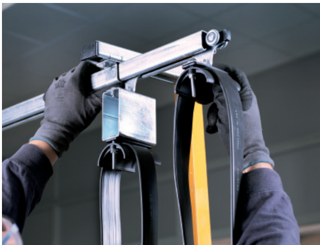
Далее вставляются кабельные тележки.
