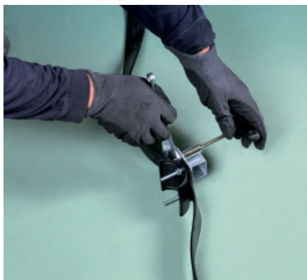
Укладка кабеля вдоль линии и определение расстояния между тележками, установка фиксации концевого зажима RG3504 с помощью болтов М6.
