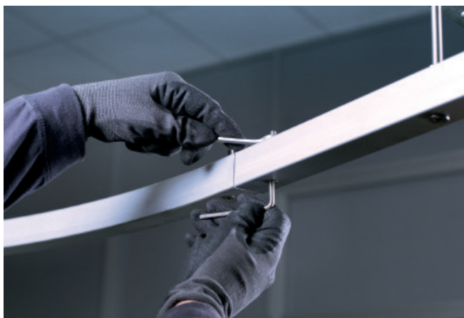
Затяжка соединений секций осуществляется с помощью двух болтов, данная операция повторяется до окончания линии.
