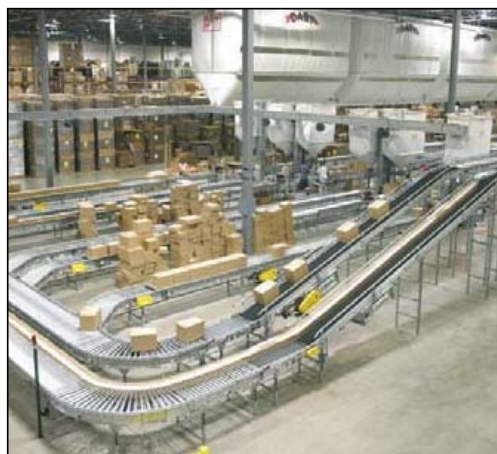
Автоматизированное складское оборудование
