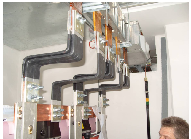
Рис. 7 Присоединение к трансформатору. ГРЩ, административное здание, метро Семёновская, г. Москва.
