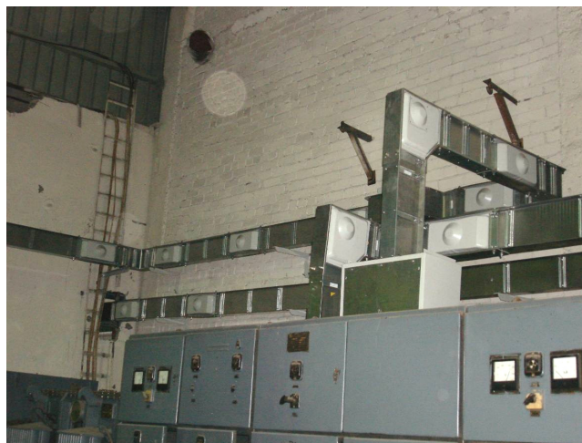
Рис.1 Применение комплекта крышек угловых У5137Р для разъёмного соединения шин секций шинпровода на РП18А ОАО «СОЭМИ».
