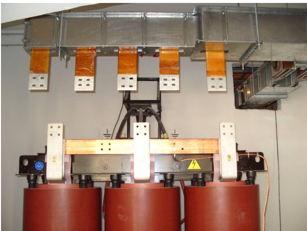
Рис. 7 Присоединение к трансформатору. ГРЩ, административное здание, метро Семёновская, г. Москва.
