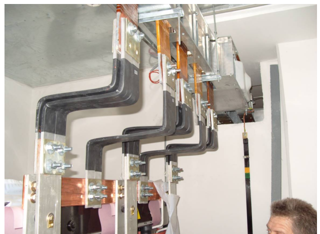
Рис. 7 Присоединение к трансформатору. ГРЦ, административное здание, метро Семёновская, г. Москва.
