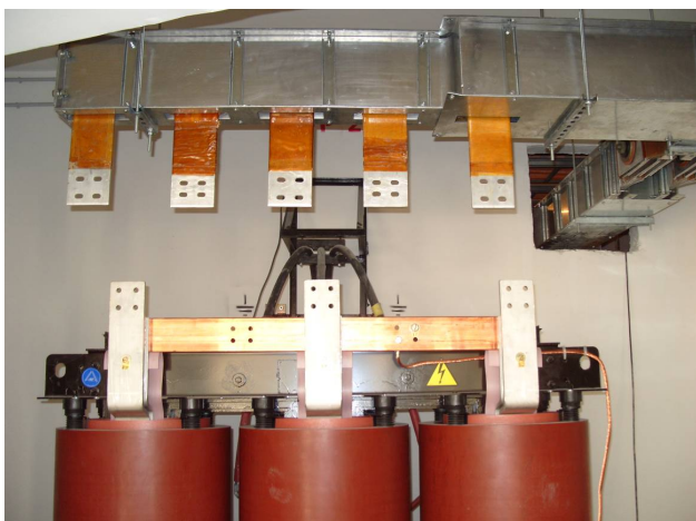
Рис. 7 Присоединение к трансформатору. ГРЦ, административное здание, метро Семёновская, г. Москва.
