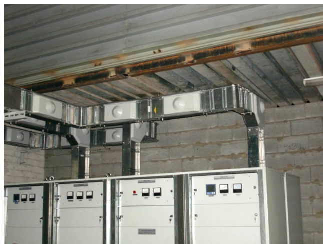
Рис.1 Применение комплекта крышек угловых У5137Р для разъёмного соединения шин секций шинопровода на РП18А ОАО «СОЭМИ».
