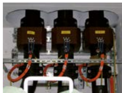
Пример установки трансформаторов тока
