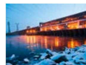
Новосибирская ГЭС, г. Новосибирск
