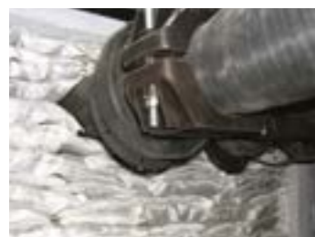
Закладка проема противопожарными подушками
