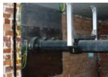
Заделка проема металлическими плитами
