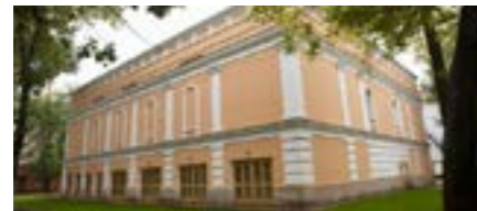
ПС Юсуповская, г. Санкт-Петербург
