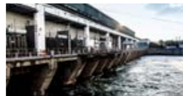
Новосибирская ГЭС, г. Новосибирск
