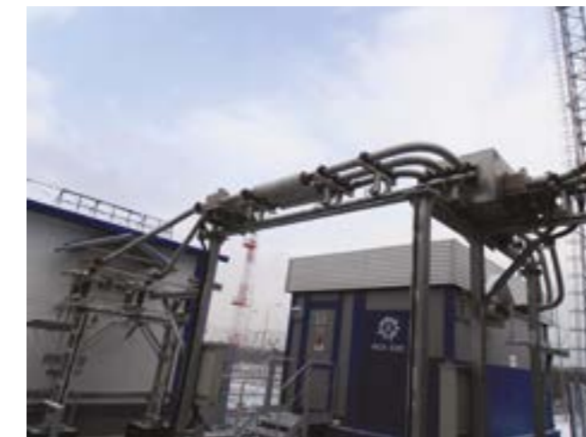
Подключение к разъединителю
