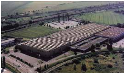
Завод по производству шинопроводов Canalis в Дижоне (Франция)
