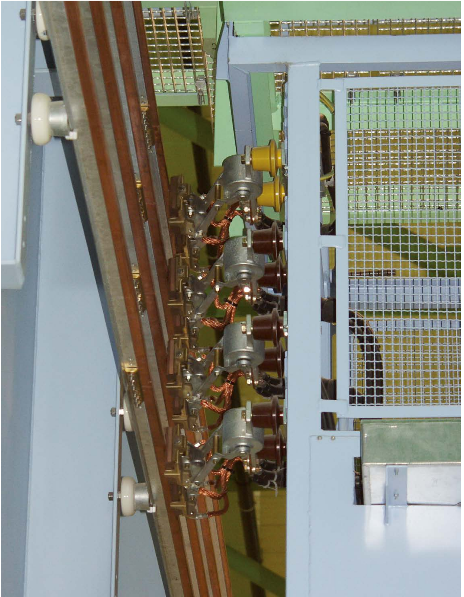
F-Schiene mit VDB-Isolatoren und GSV8 Stromabnehmer
