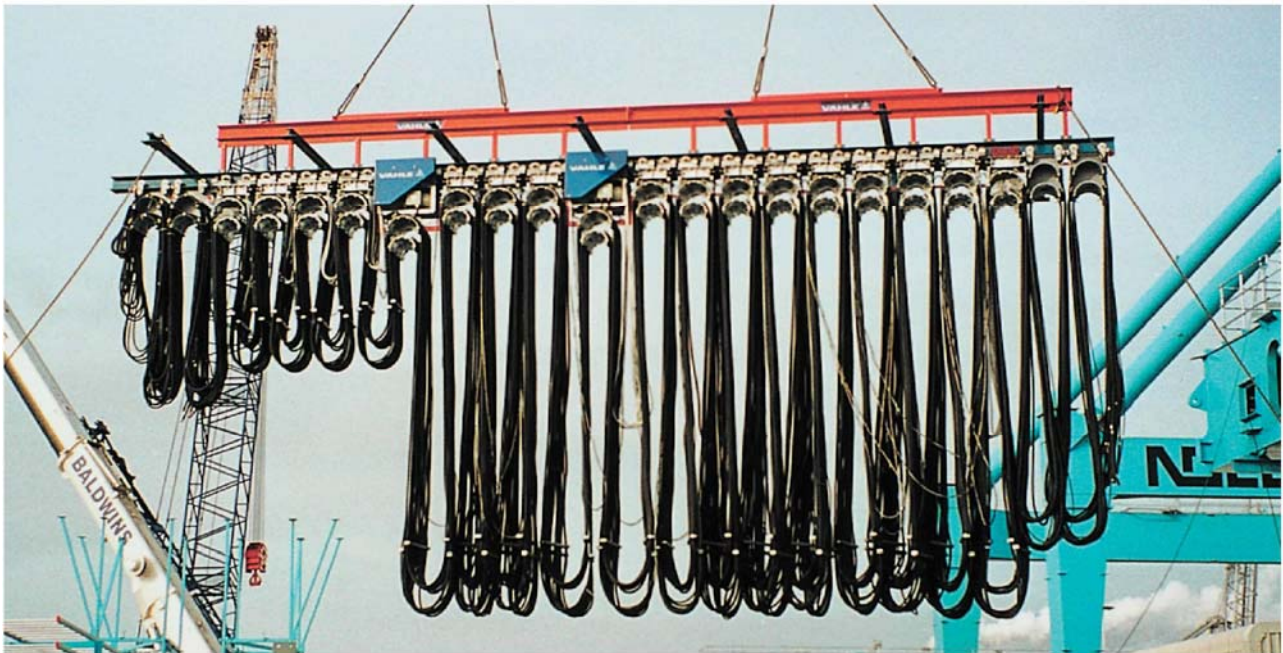
Монтаж установки кабельных тележек в порту Роттердама
